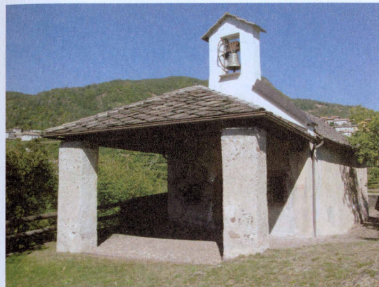
Lisignago, Chiesa di San Leonardo, veduta dall'esterno
